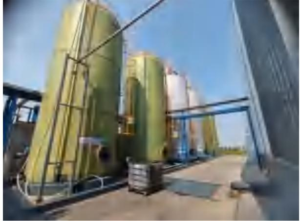
超滤进水储罐和反渗透进水储罐
